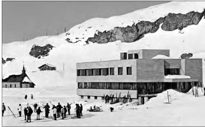
Das Kernser Ski- und Berghaus nach dem Umbau: Zimmer, Massenlager und gepflegte Küche
